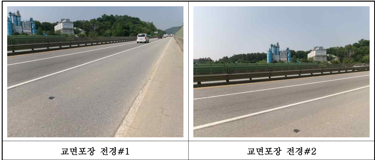
【사진 1.3.21】 교면포장 전경
