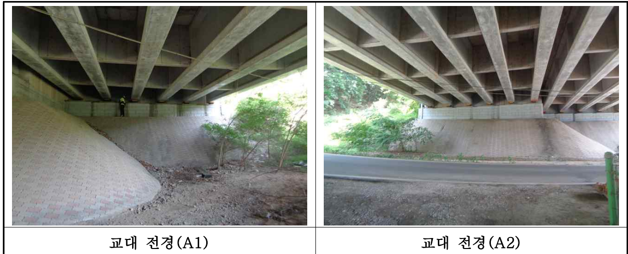
【사진 1.3.8】 교대 전경
