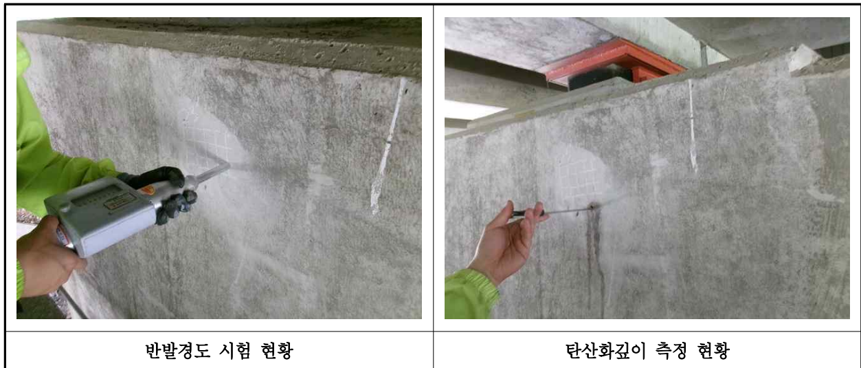
【사진 1.4.1】 콘크리트 내구성조사 현황
