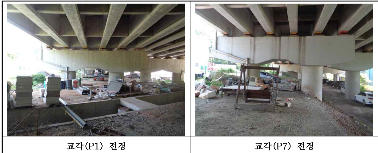
【사진 1.3.10】 교각 전경
