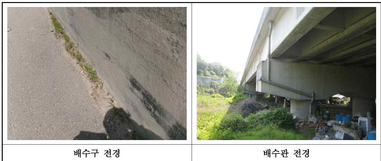
【사진 1.3.23】 배수시설 전경
